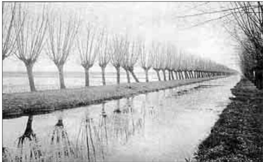
A sinistra: la campagna era spesso soggetta agli allagamenti; sotto il Ponte della Sbarra, con il quale l'antica strada per Bagnolo e per la Bassa scavalcava il Rodano
